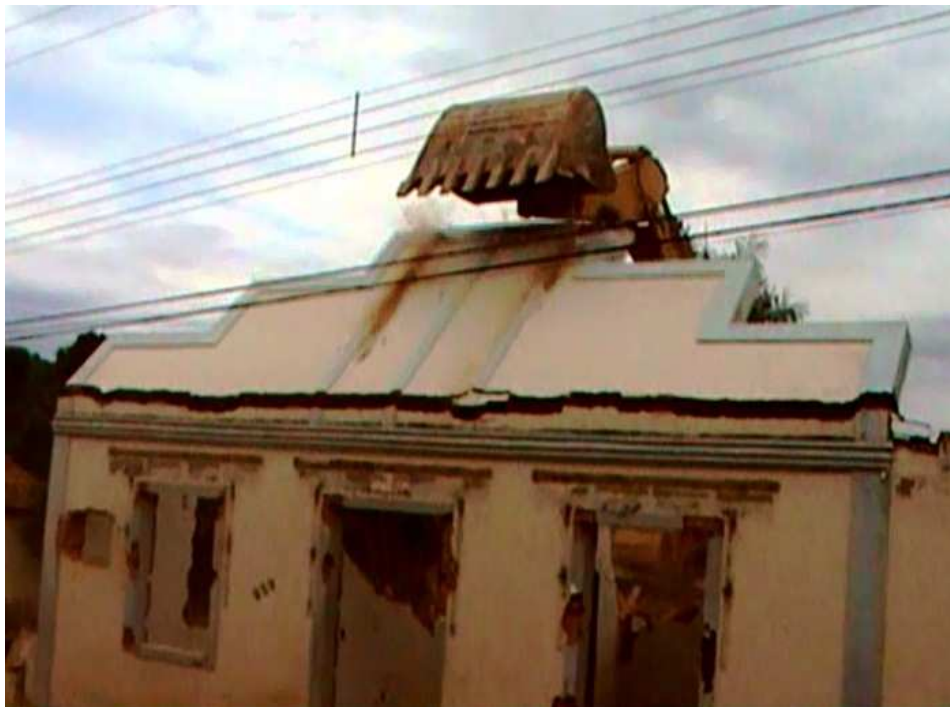
Figura 6: Demolição da Prefeitura Municipal de Itueta Fonte: Arquivos de Paulo Venturim (2004)
