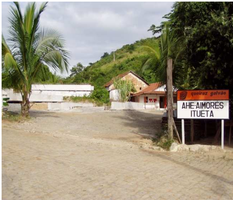
Figura 10: Canteiro de obras, Itueta velha Fonte: Arquivo de Paulo Venturim (2002)
