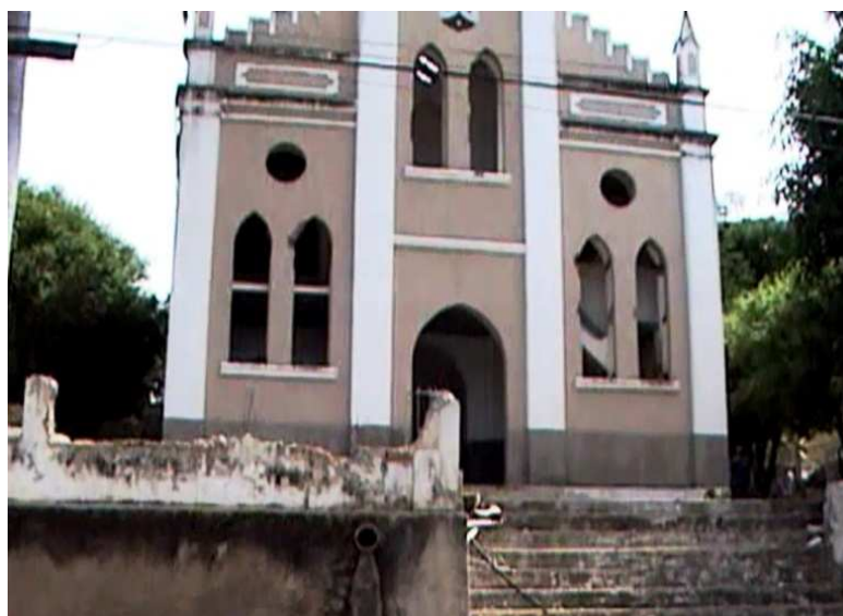
Figura 8: Demolição da Igreja de São João Batista Fonte: Arquivos de Paulo Venturi (2004)
